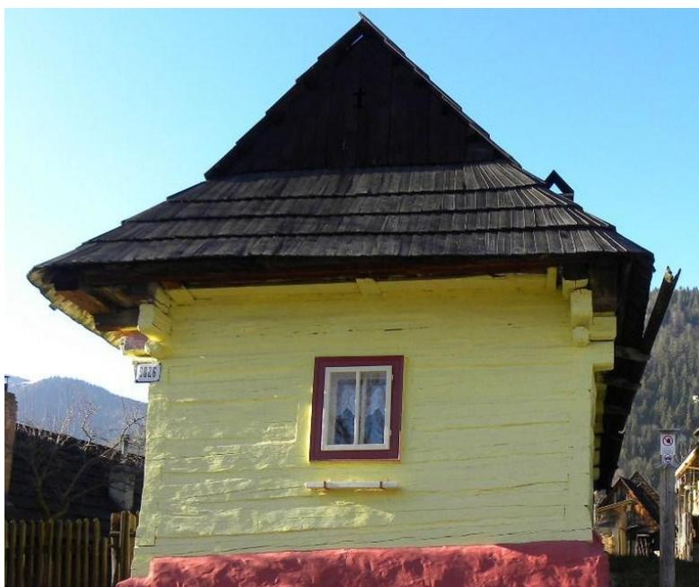
Comme on peut le voir sur cette photo, à droite, une gouttière en bois récupère et canalise l'eau de pluie. C'est le côté de l'entrée de la maison. A gauche, côté « fermé », pas de gouttière, l'eau de pluie est rejetée à distance du bâtiment. On remarquera qu'il n'y a pas de tuyau de descente d'eau pluviale, celle-ci étant aussi rejetée à distance.
