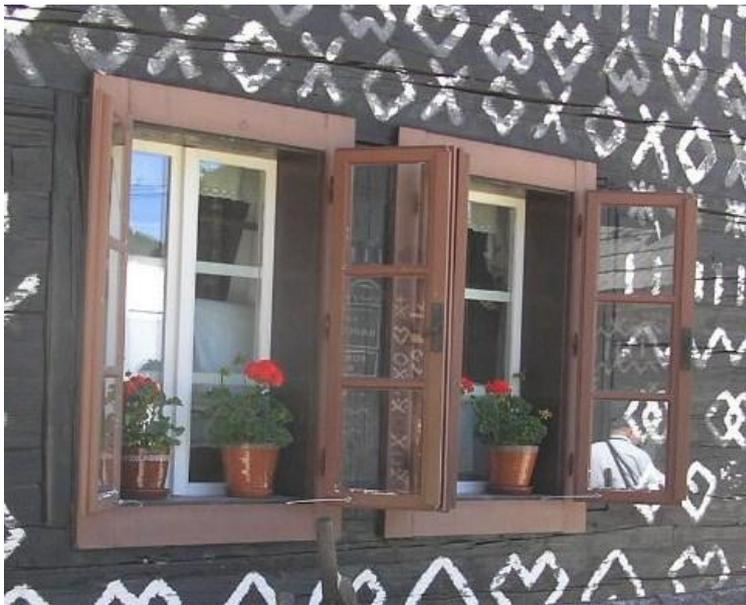
Les madriers étaient découpés pour créer des percements et on y insérait les encadrements de porte ou les ébrasements de fenêtre.
